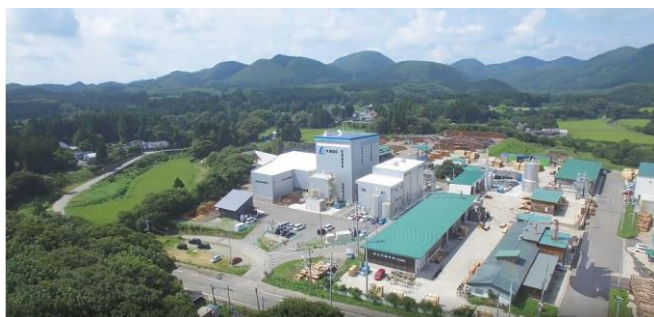
写真提供：(株)大仙バイオマスエナジー
