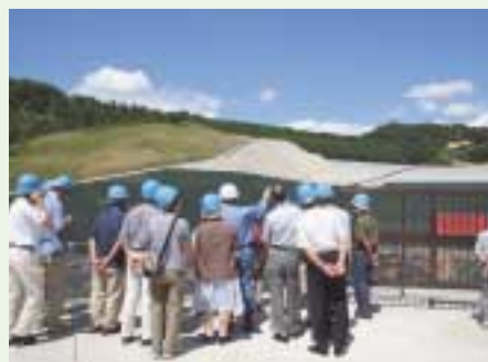
完成した最終処分場
