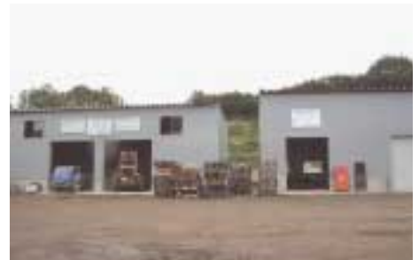
リサイクル材使用の新施設
