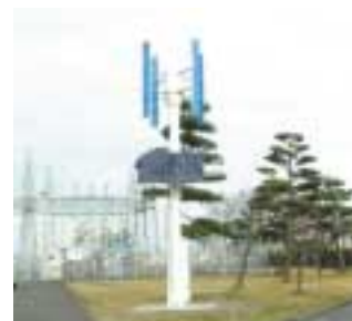
仁井田浄水場
